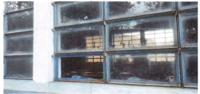
Foto 8: Sustrucción de vidrios(Módulo 4)
