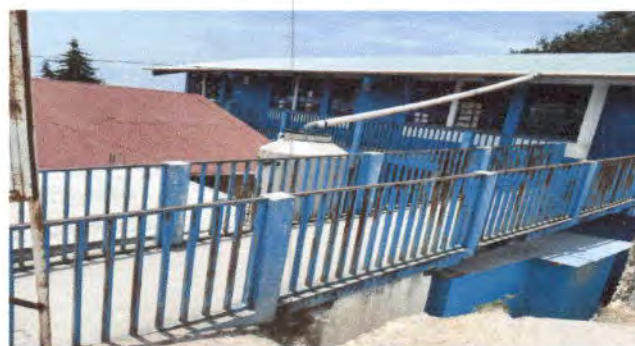
Foto 4: Mantenimiento a baranda de metal (Módulo 2)
