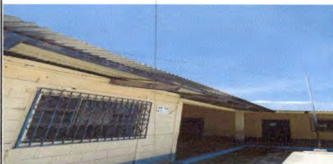
Foto 2: Pintura en muros exteriores aulas (Modulo 2)
