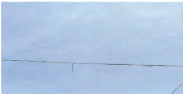
Foto 9: Reparación de cableado Eléctrico (Módulo 4)
