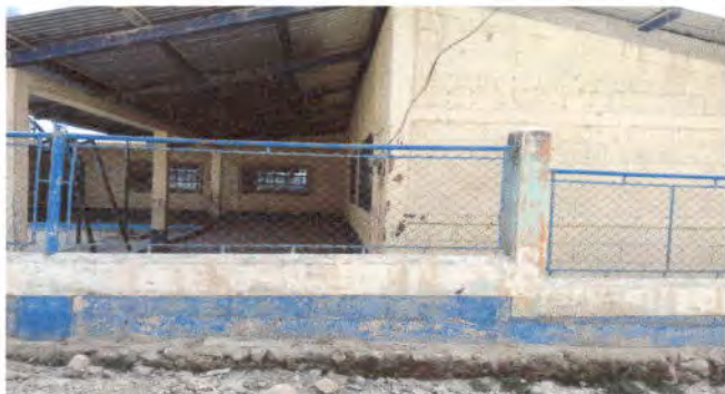
Foto 1: Pintura en muros exteriores circulación (Modulo 1)
