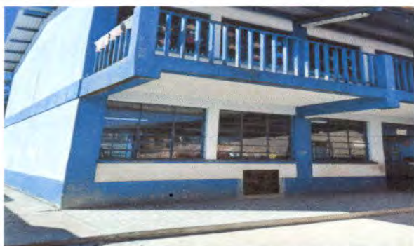
Foto 3: Pintura en muros exteriores 6 aulas de 2 niveles (Modulo 2)
